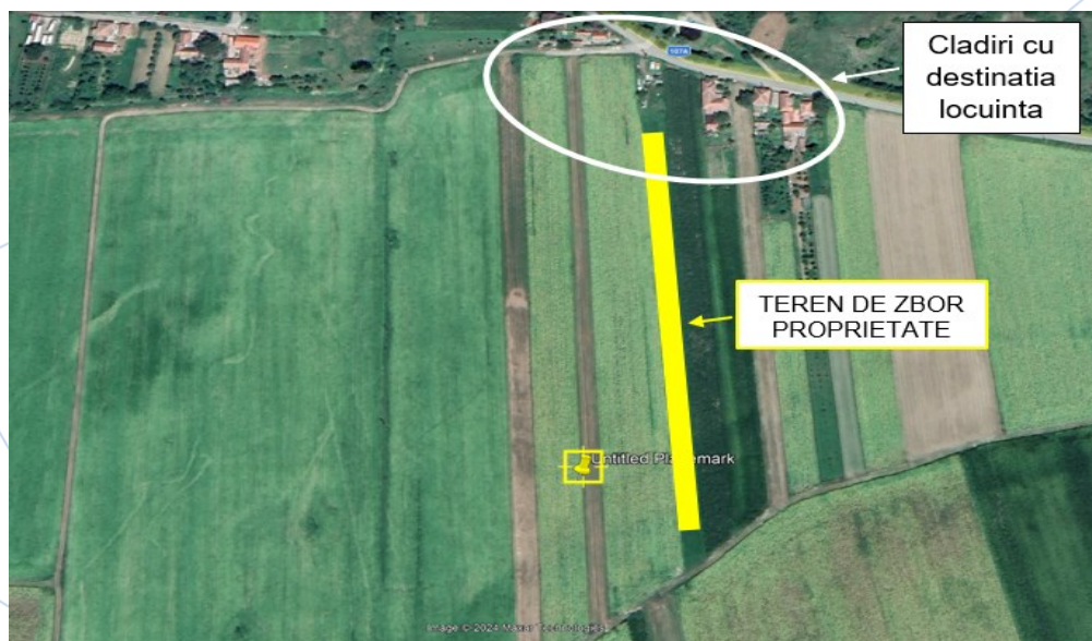
Fig.3 – Construcții în prelungirea pistei de zbor
