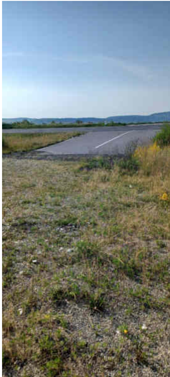
Figura nr. 7 - Aspect drum de acces existent din DN 1/E68
