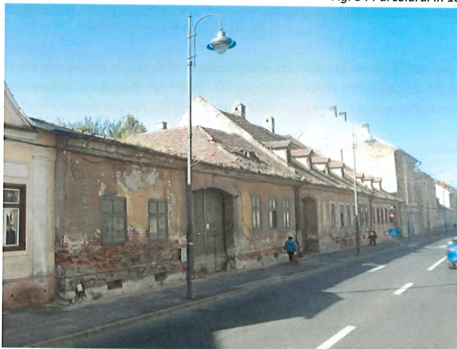
Fig. 35 Fațada casei de la nr. 11
