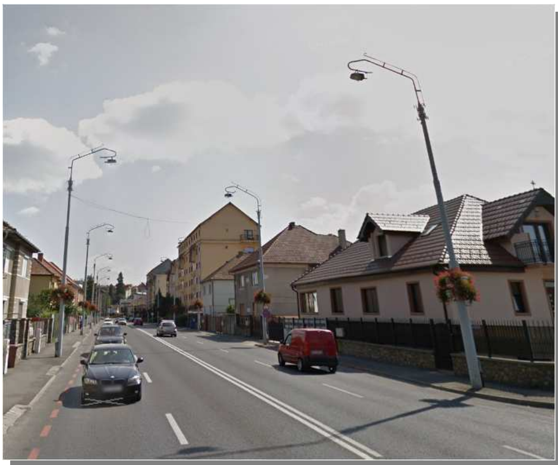
Fig. 12. – Amplasare cabluri în subteran, Foto – Captură www.google.com
