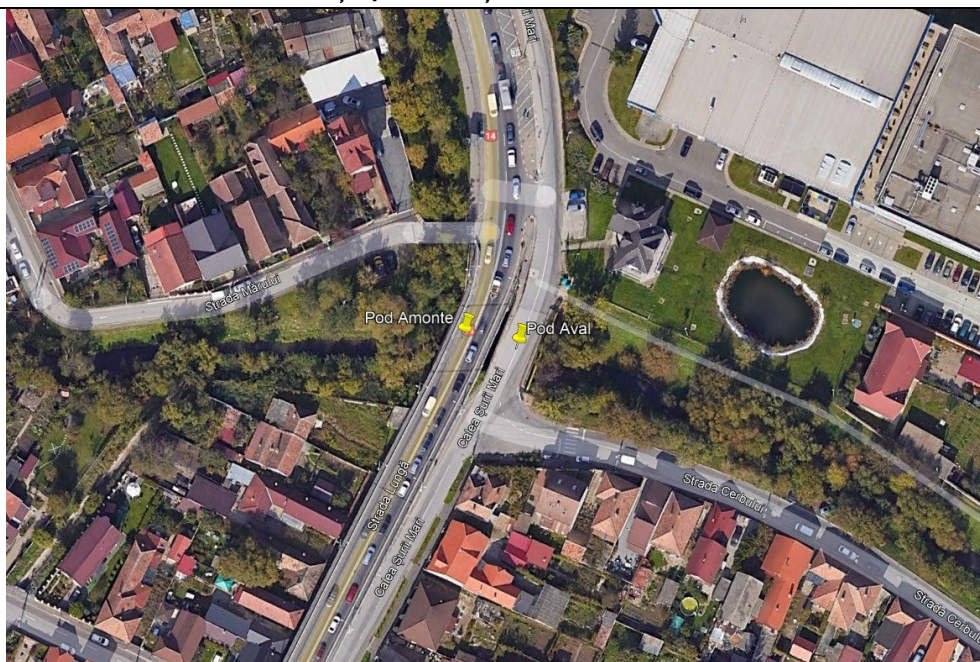
Figura 3 — Amplasamentul podului amonte peste paraul Rossbach — vedere aeriana, str. Lunga, Municipiul Sibiu
