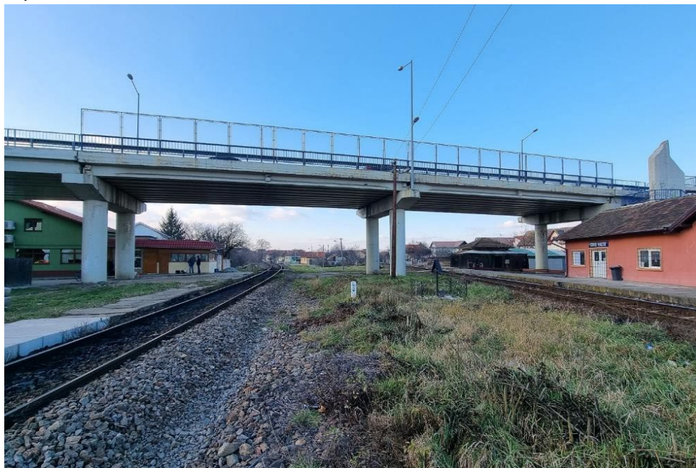
Figura 1 — Viaductul Calea Șurii Mari — vedere generală a structurii existente, Municipiul Sibiu
